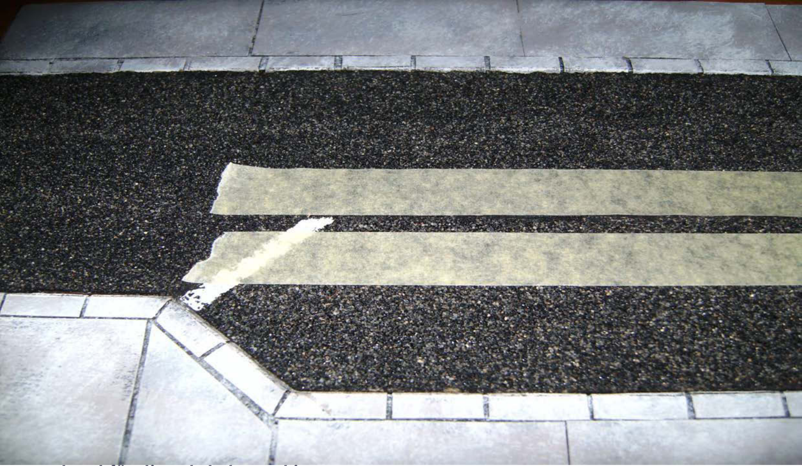
Kreppband für die Fahrbahnmarkierung
